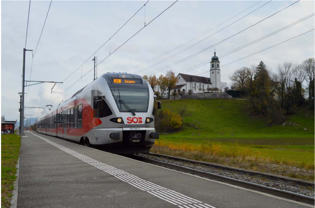
Bildlegende: Die Bahninfrastruktur im Rheintal wird für 215 Millionen Franken ausgebaut. Unter anderem ist in Rüthi eine Doppelspur geplant, damit der REX-Halbstunden-Takt realisiert werden kann. Foto: pd.
